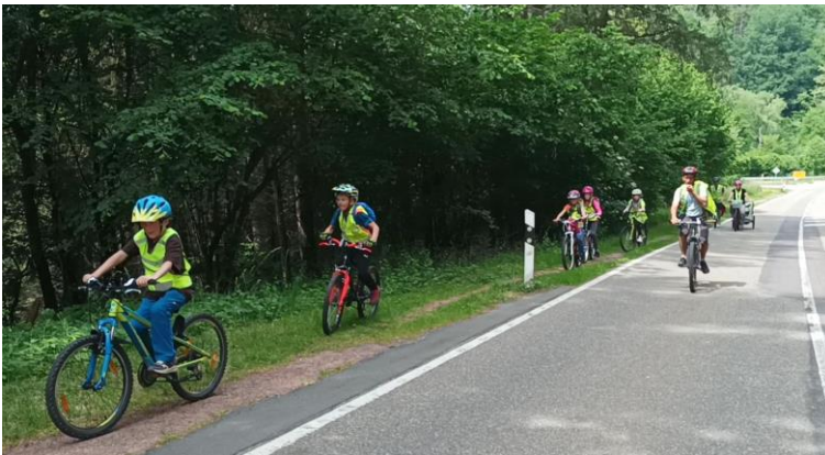
Fehlende Radspur an der Landesstraße
