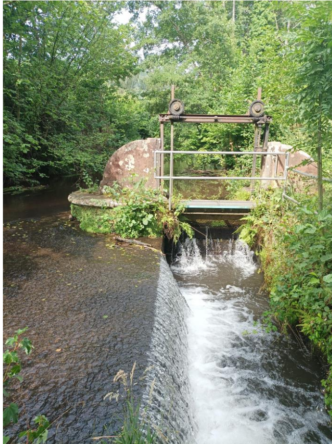
Schließanlage der Queich bei Annweiler
